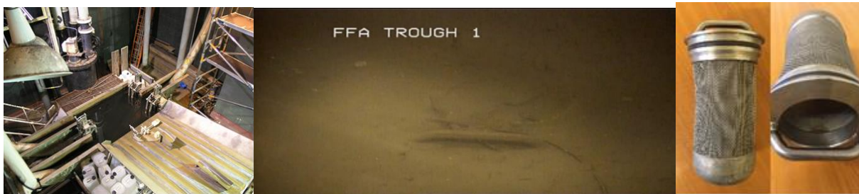
Llun 7 – Llun o ardal Cafn Llenwi Fflasgiau, slwtsh yn y Cafn ac enghraifft o Hidlyddion sydd angen tynnu malurion ar hyn o bryd
