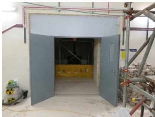
Llun 8 – Delwedd o'r drysau C2/C3 (rheolaeth radiolegol) sydd wedi'u gosod ar gyfer mynediad i ystafell Mesanîn y Dwyrain.
